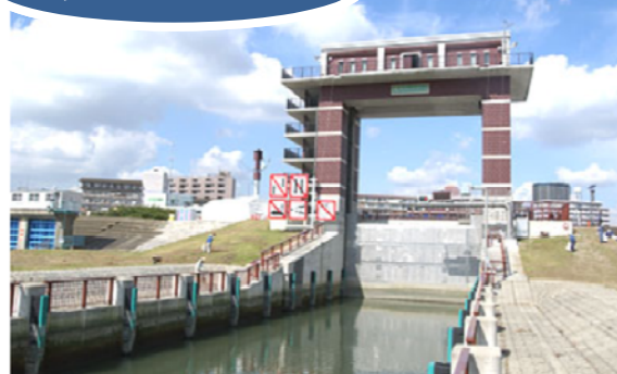
荒川ロックゲート
