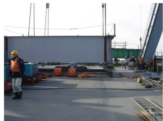
桁落とし込み完了
