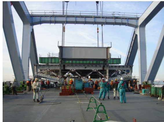
桁落とし込み状況①
