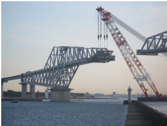
架設状況（遠景）
