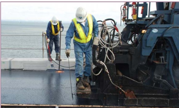
③端部仕上げ（奥）及び厚さ確認（手前）
