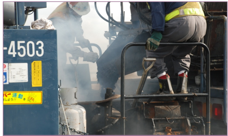
②合材投入状況
