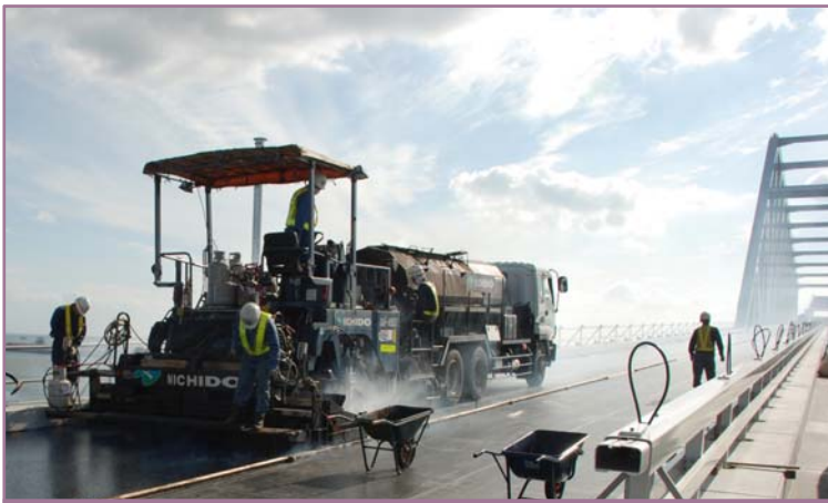
①ガスアスファルト舗設状況
