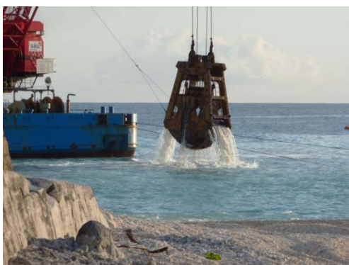
浚渫作業状況
