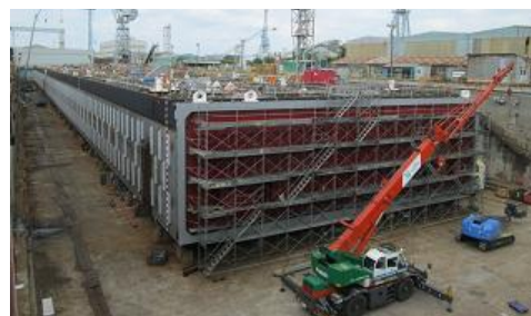
製作ドック内の沈埋函の鋼殻 (手前が2号函、奥が1号函)
