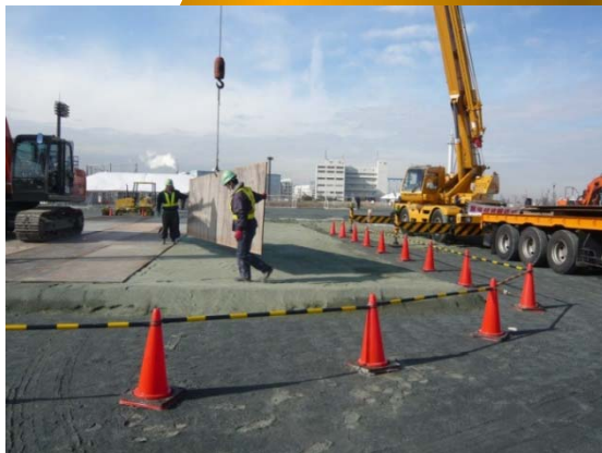
液状化した地盤を整地後、敷鉄板を敷設
