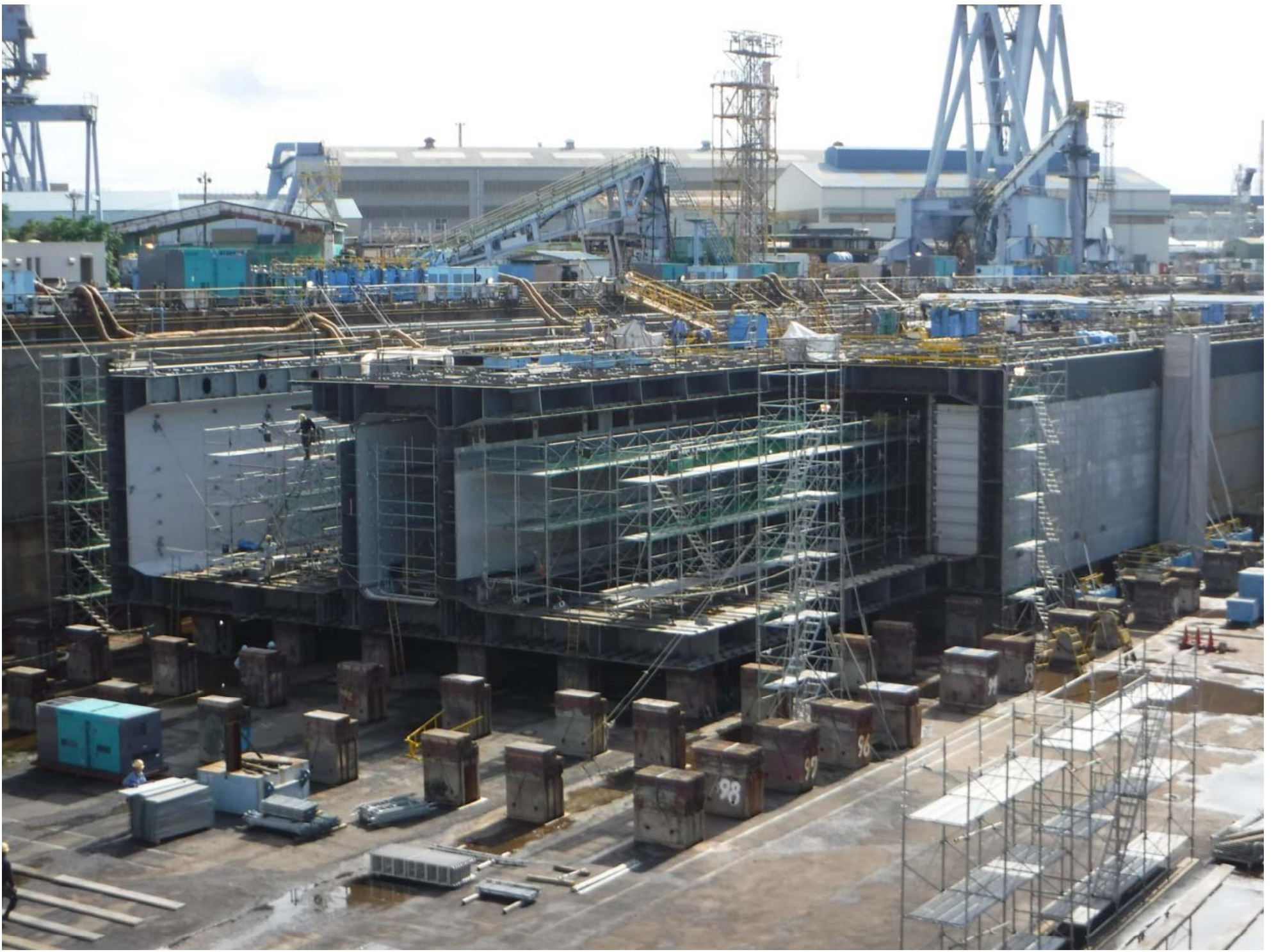
南北線沈埋函（3号函）製作【東京港湾事務所】
