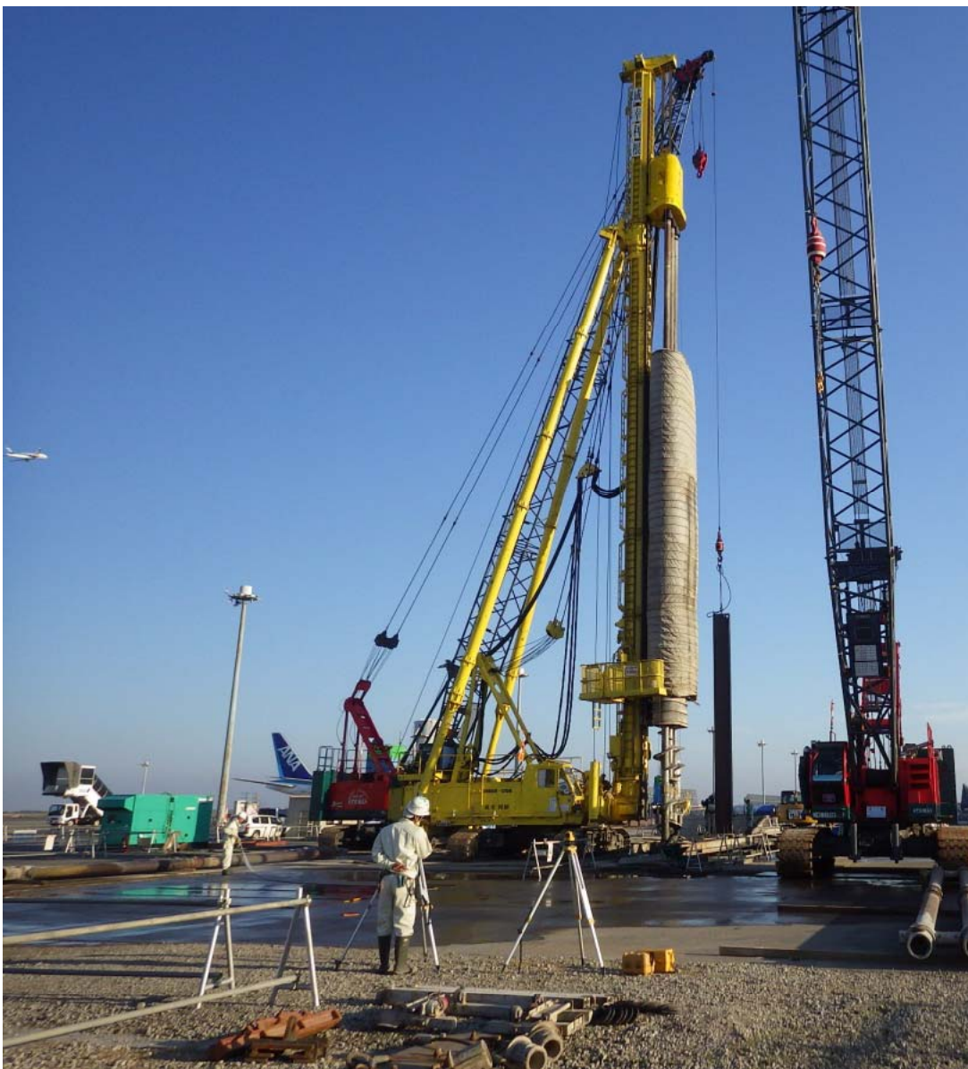
際内トンネル築造工事【東京空港整備事務所】
