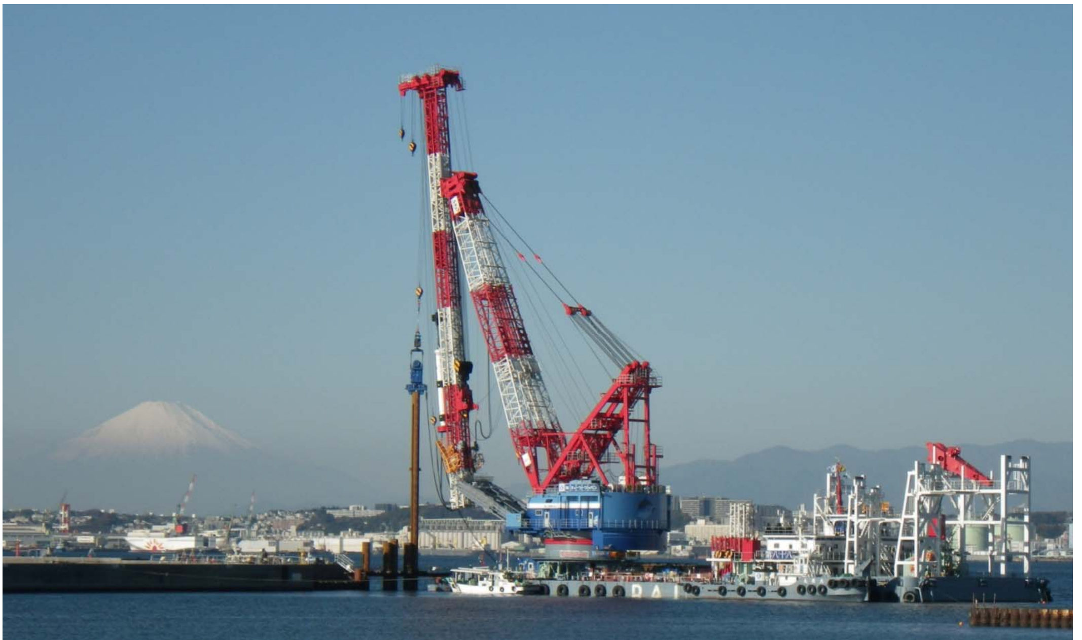
南本牧地区の岸壁築造【京浜港湾事務所】
