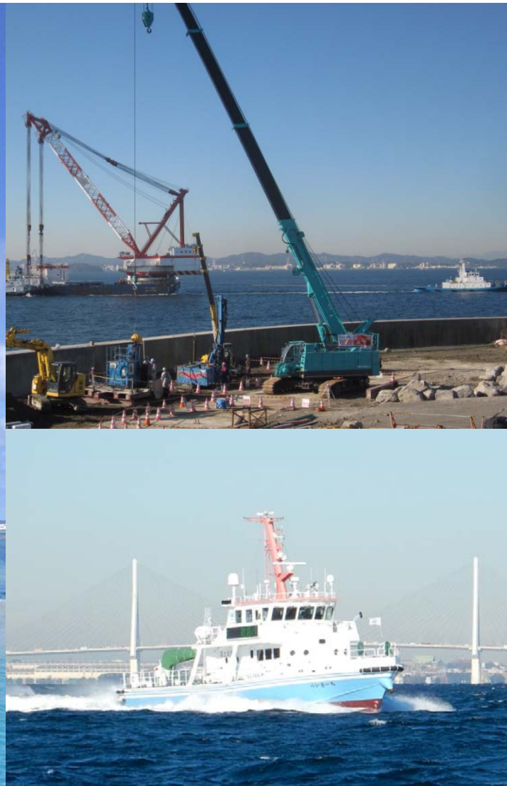
第二海堡の護岸整備（上）と航路パトロール（下） 【東京湾口航路事務所】
