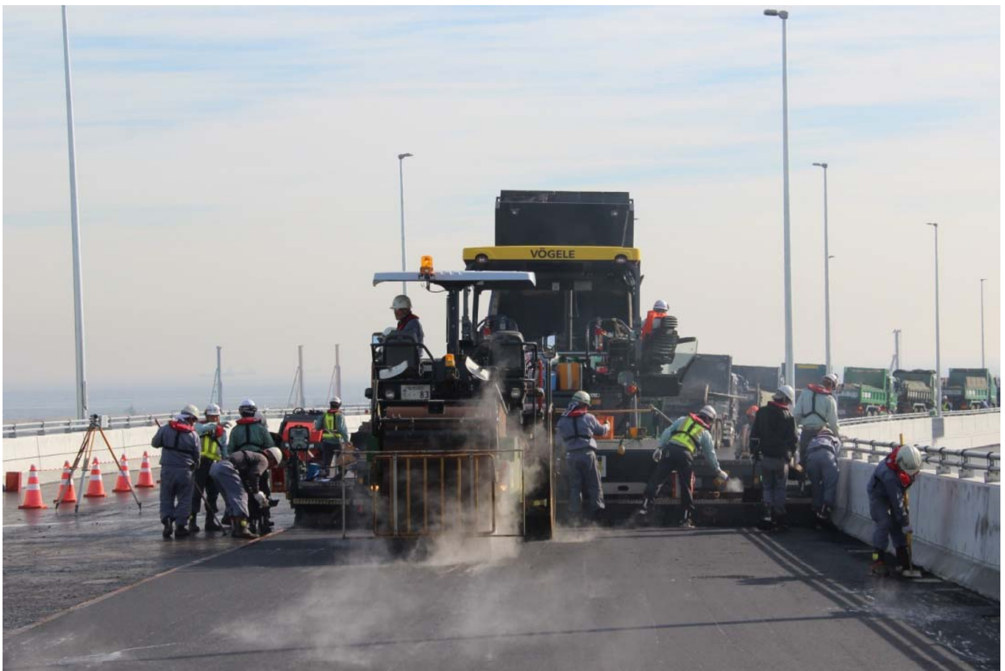
横浜臨港道路の橋面工事【京浜港湾事務所】
