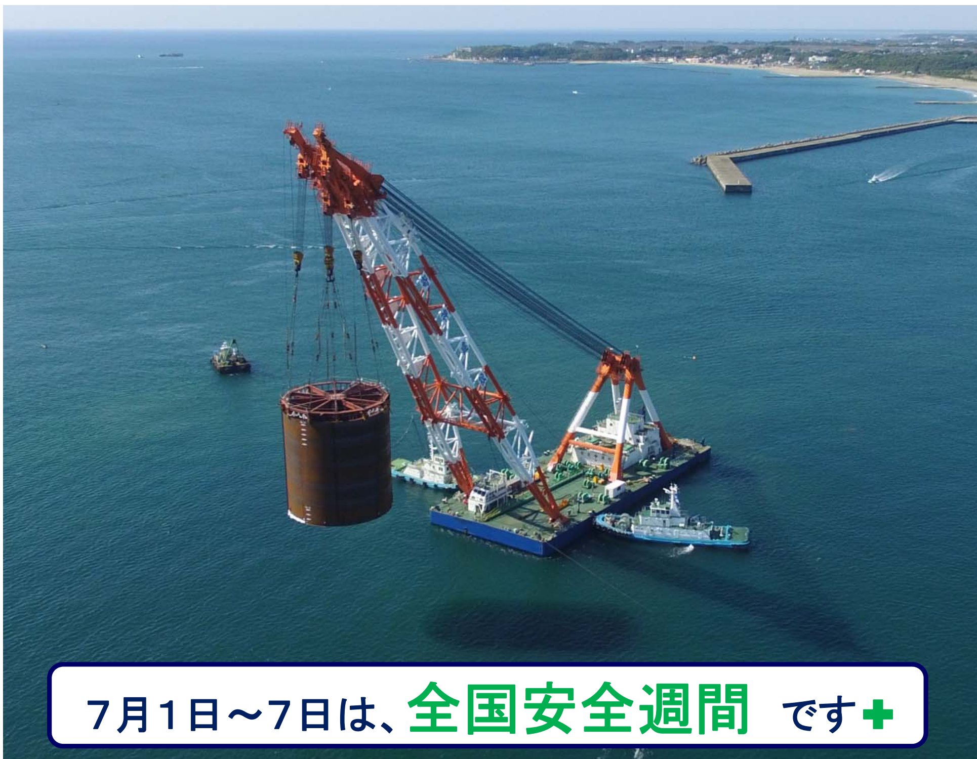
茨城港の護岸築造（セル据付）【鹿島港湾・空港整備事務所】
