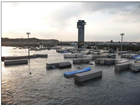
▲ 第3ふ頭（フェリーターミナル）の浸水状況
