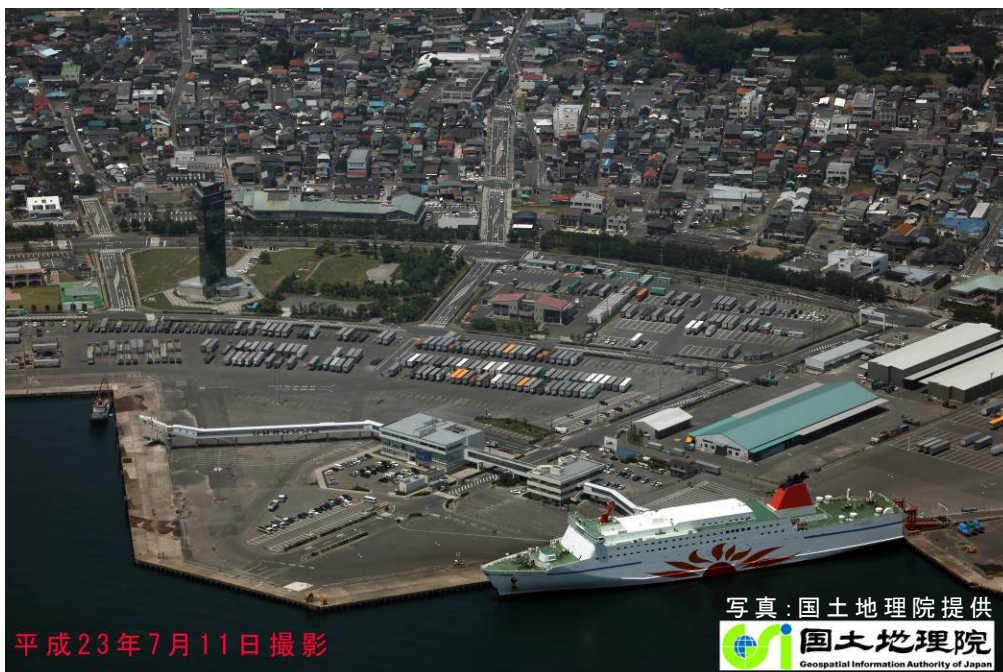
▲早期の完全復旧が望まれる第3ふ頭のフェリーターミナル
