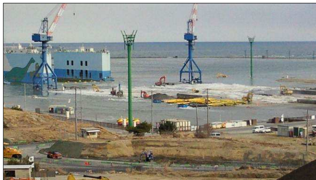
▲作業基地の浸水状況
