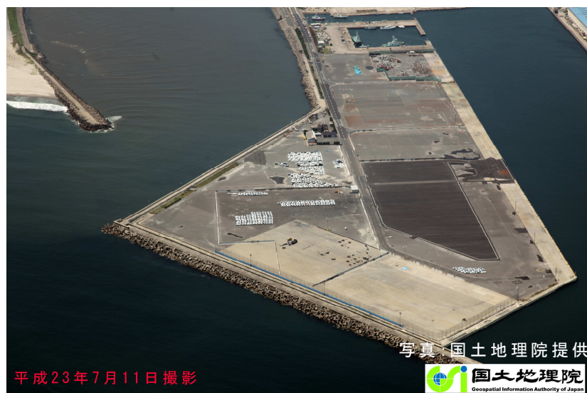
▲地震による沈下で荷捌き地に段差が生じた第5ふ頭
