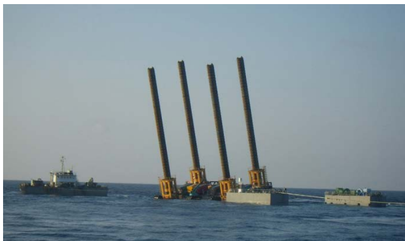
写真2-6 浮上中に傾斜した栈橋(6:39時点)
