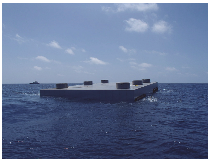
写真 2 - 7 転覆し裏返しになった棧橋
