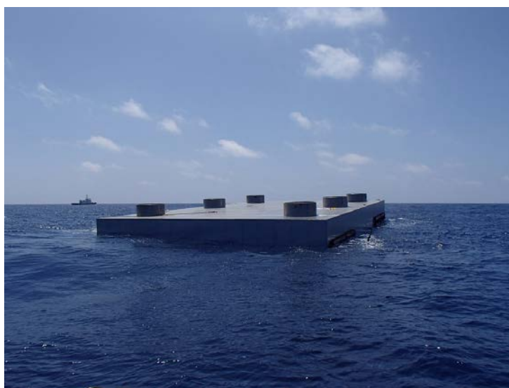
写真 2 - 7 転覆し裏返しになった棧橋
