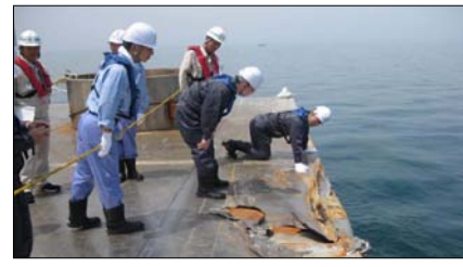
棧橋の現地調査
