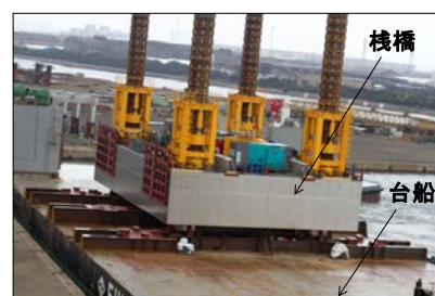
写真2-2 棧橋を台船に積載
