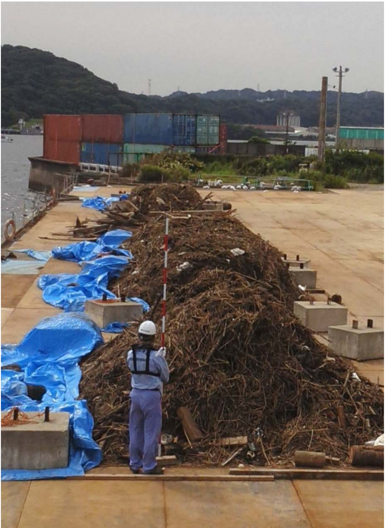
漂流物の仮置き状況(全景)
