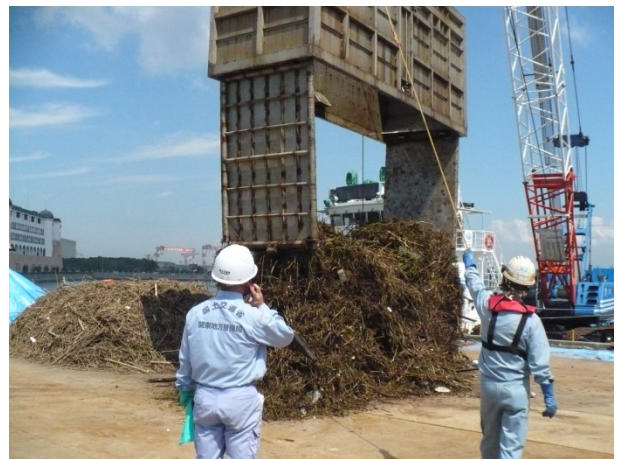
漂流物の陸揚状況1
