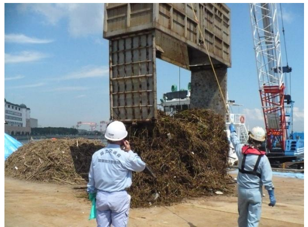
漂流物の陸揚状況1
