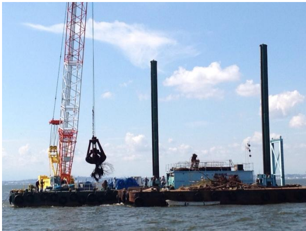
クレーン台船による流木の回収状況 ((一社)日本埋立浚渫協会による回収)
