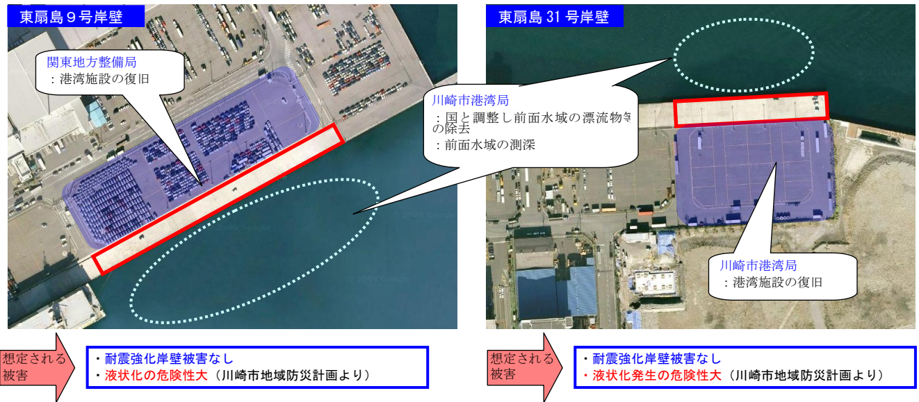
図 緊急輸送道路、航路、ヘリポート等の復旧
