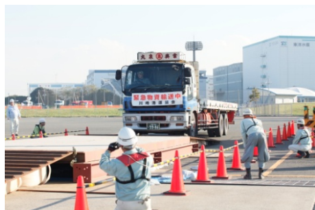
31号岸壁背後での仮設橋梁設置
