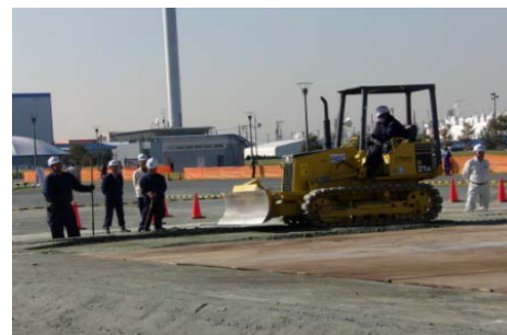
拠点内液状化応急復旧・大型敷鉄板敷設
