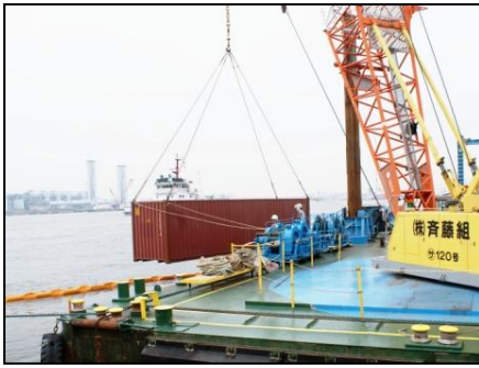
緊急確保航路啓開①
