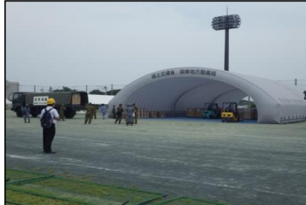
エアテント設置
