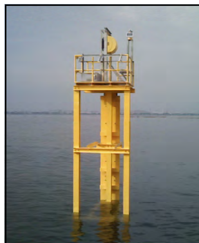
浦安沖に設置した観測機器
