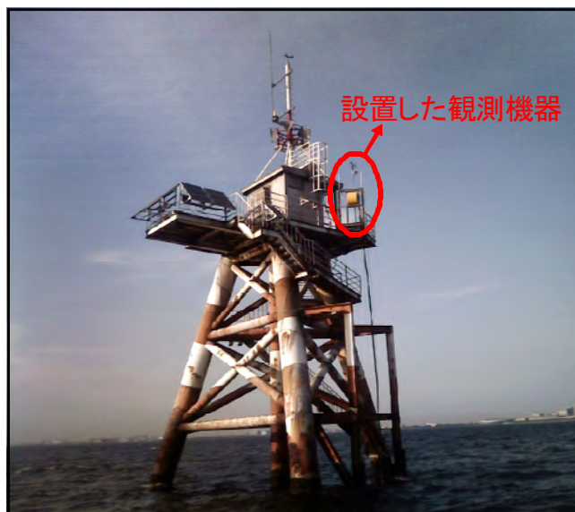
千葉港波浪観測塔
