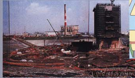
千鳥町陸上トンネル及び換気所建設中
