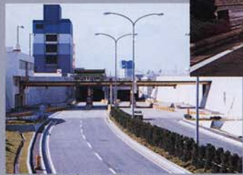
東扇島側海底トンネル入口
