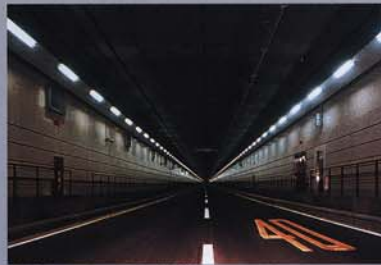
完成したトンネル車道部
