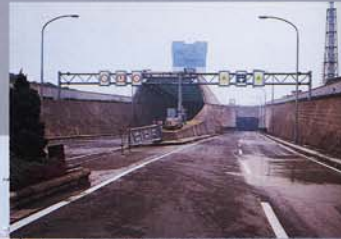
千鳥町側海底トンネル入口
