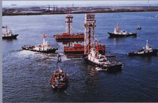
沈埋函 昭和52年8月27日1号函沈設準備
