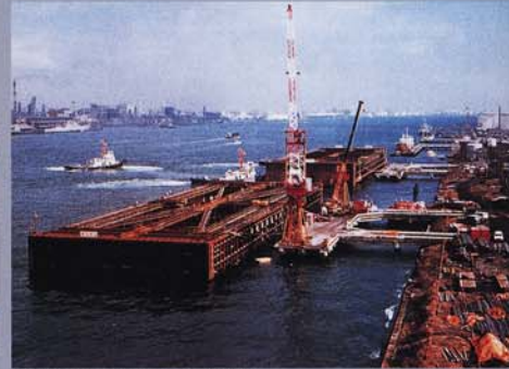
積装棧橋と積装中の沈埋函
