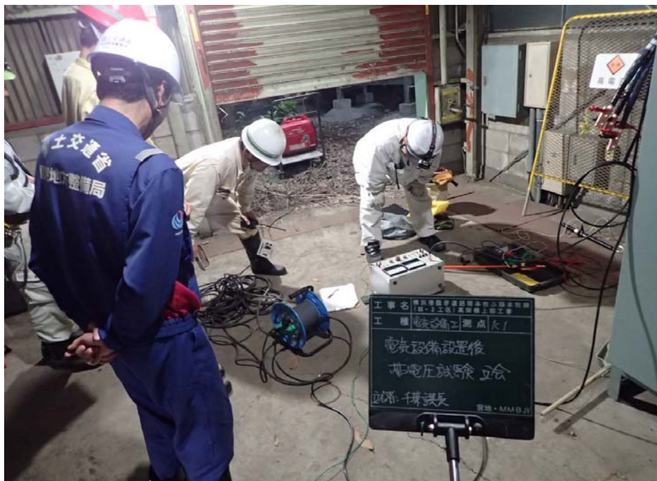
写真② 配線完了後確認状況
