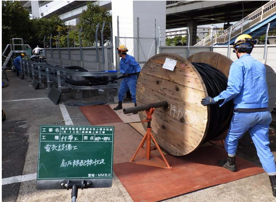
写真① 電気ケーブル配線状況
