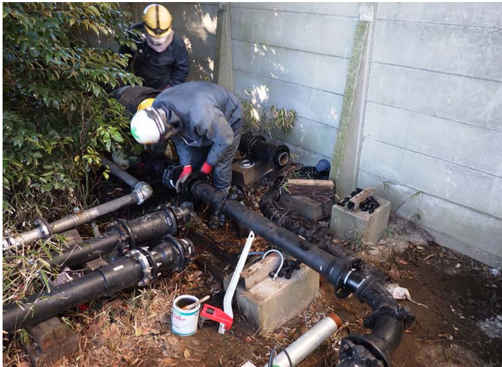
写真① 配管状況
