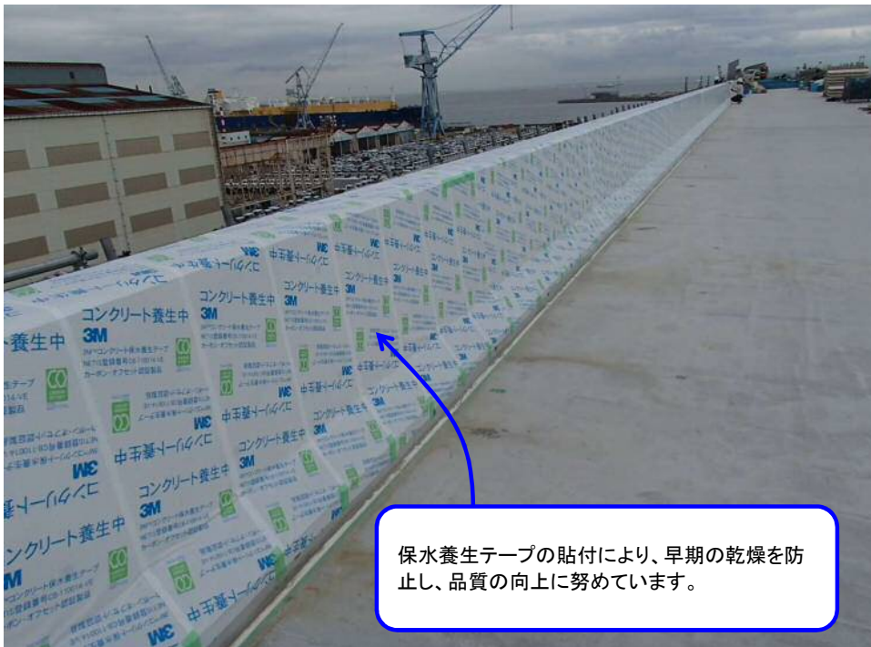
写真② 壁高欄コンクリートの養生状況(上り線)
