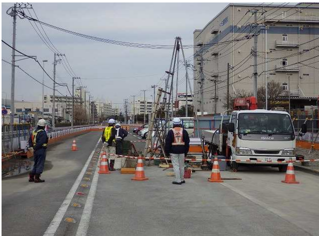
写真② 調査工(ボーリング)施工状況
