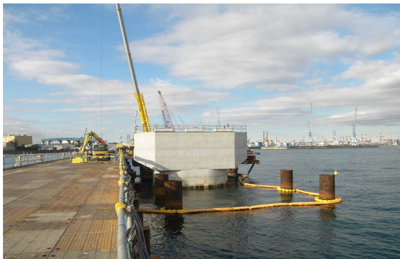
P3橋脚 構築完了
