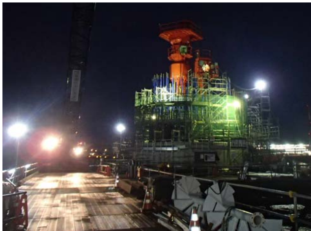
沈下掘削状況
