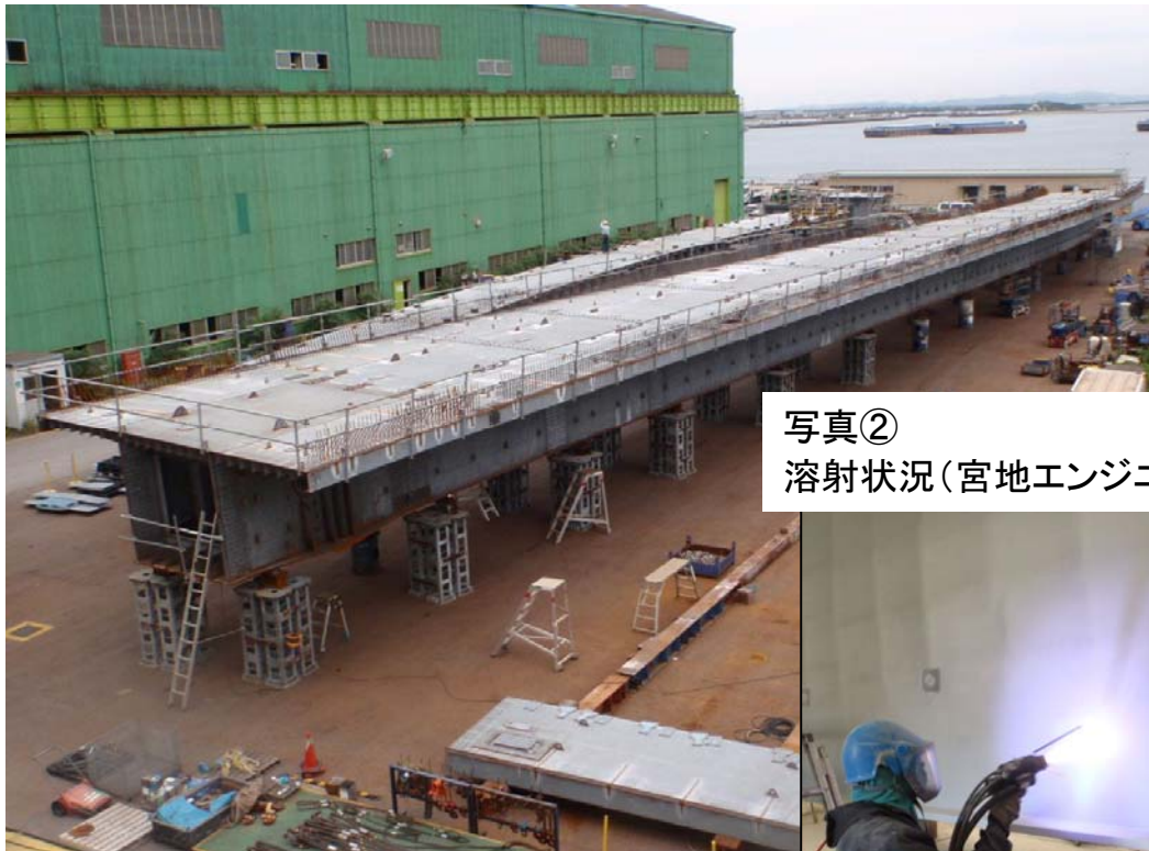
写真① II工区 仮組立状況(エム・エムブリッジ千葉工場)
