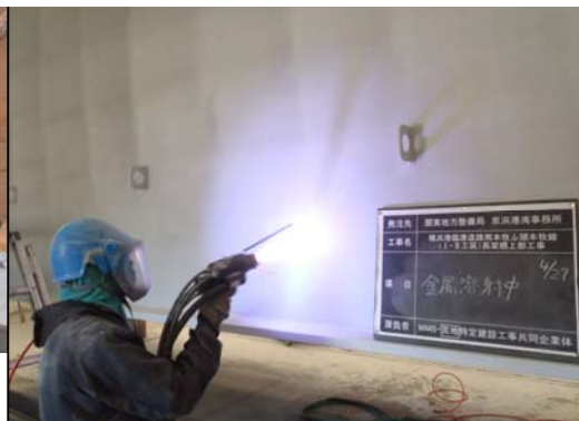
写真② 溶射状況(宮地エンジニアリング千葉工場)
