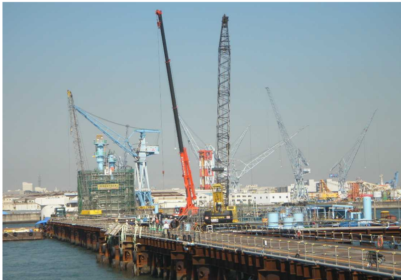
P2・P3橋脚構築は10ロット完了、P3橋脚は沈下掘削完了
