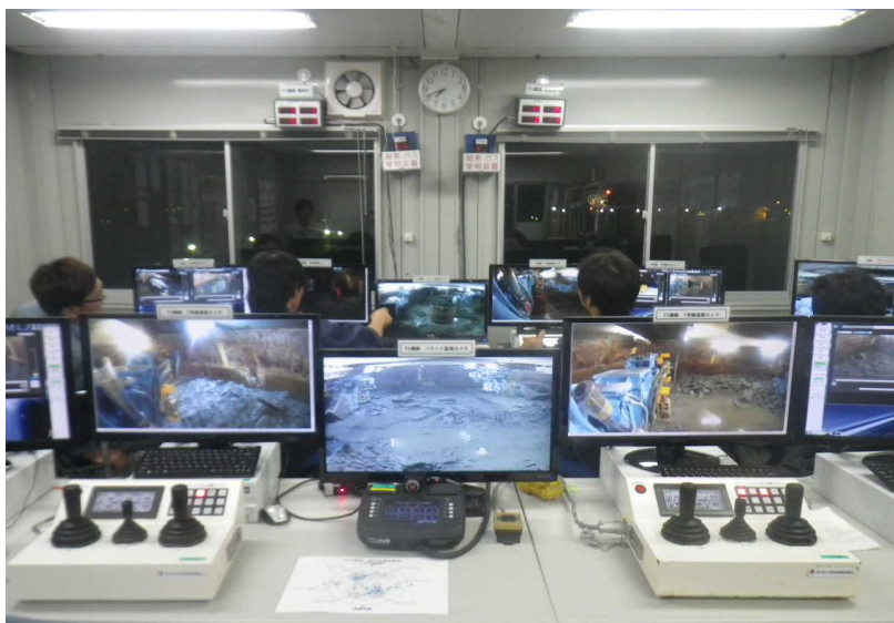
沈下掘削 遠隔機械掘削状況
