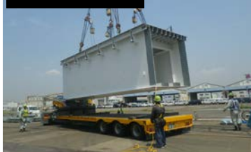
桁搬入・荷卸
