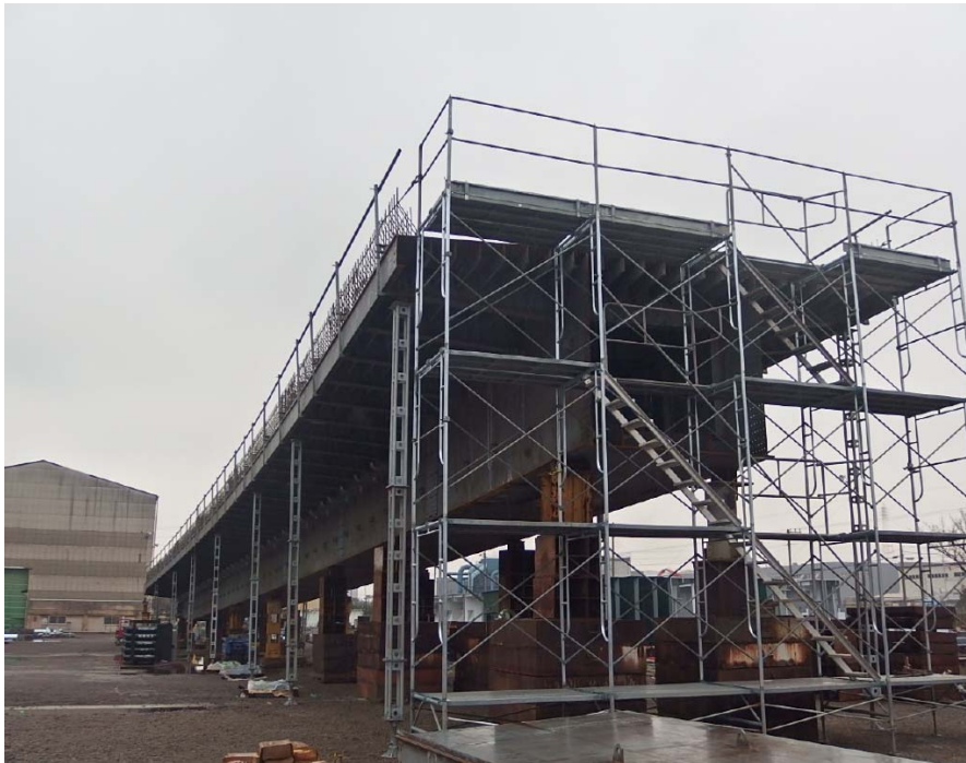
II 工区仮組立状況(I P3-II P1) 【宮地 千葉工場】
