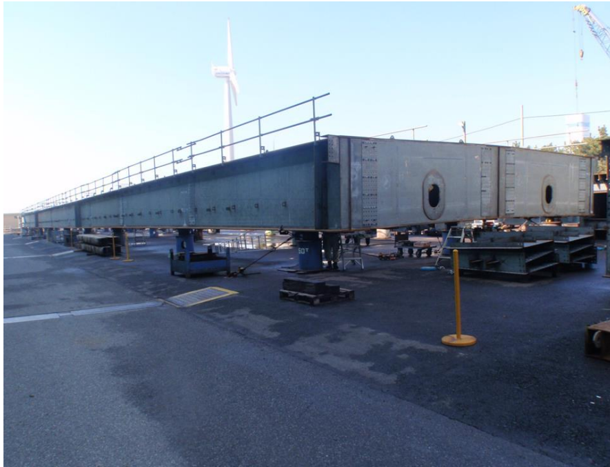
I 工区仮組立検査状況(J3-S2) 【三菱 千葉工場】
