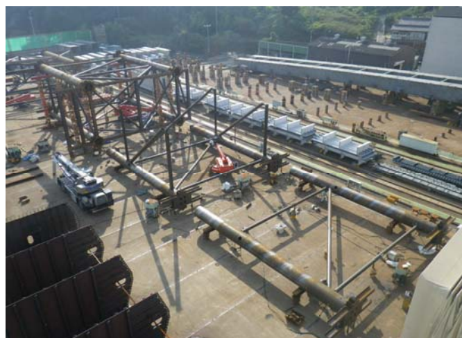
立体ブロック組状況-1
