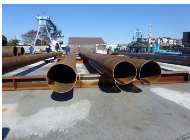
ブロック加工状況
