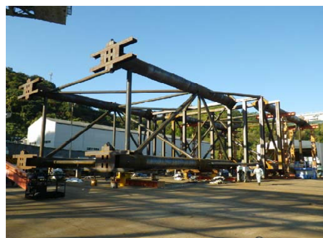
立体ブロック組状況-2
