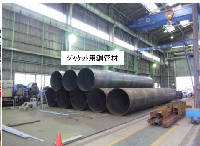
ジャケット加工状況(横浜工場)
