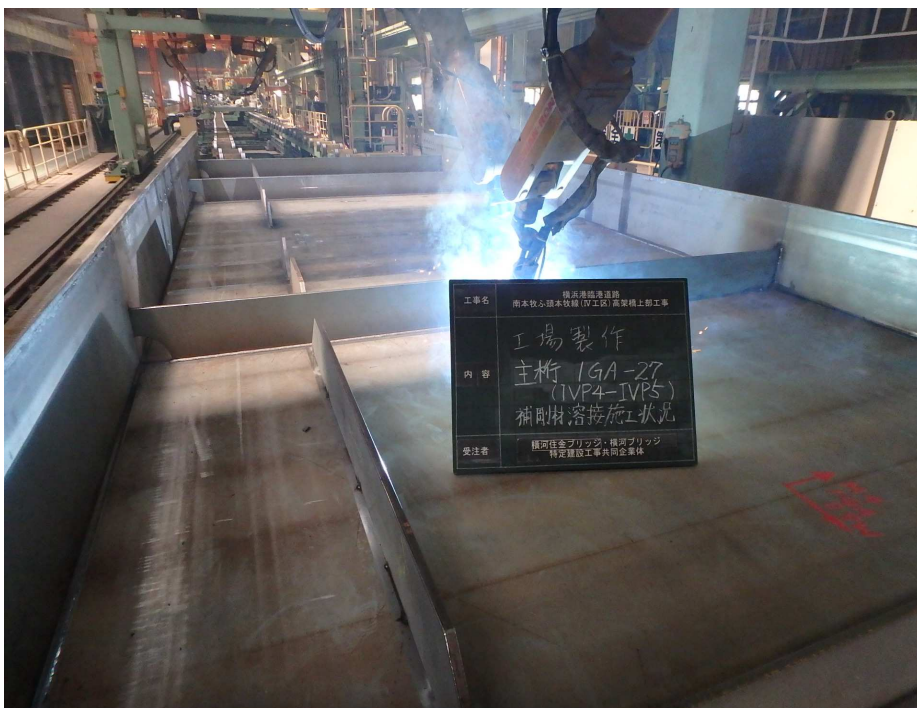
橋梁部材の溶接状況(ロボット溶接)
