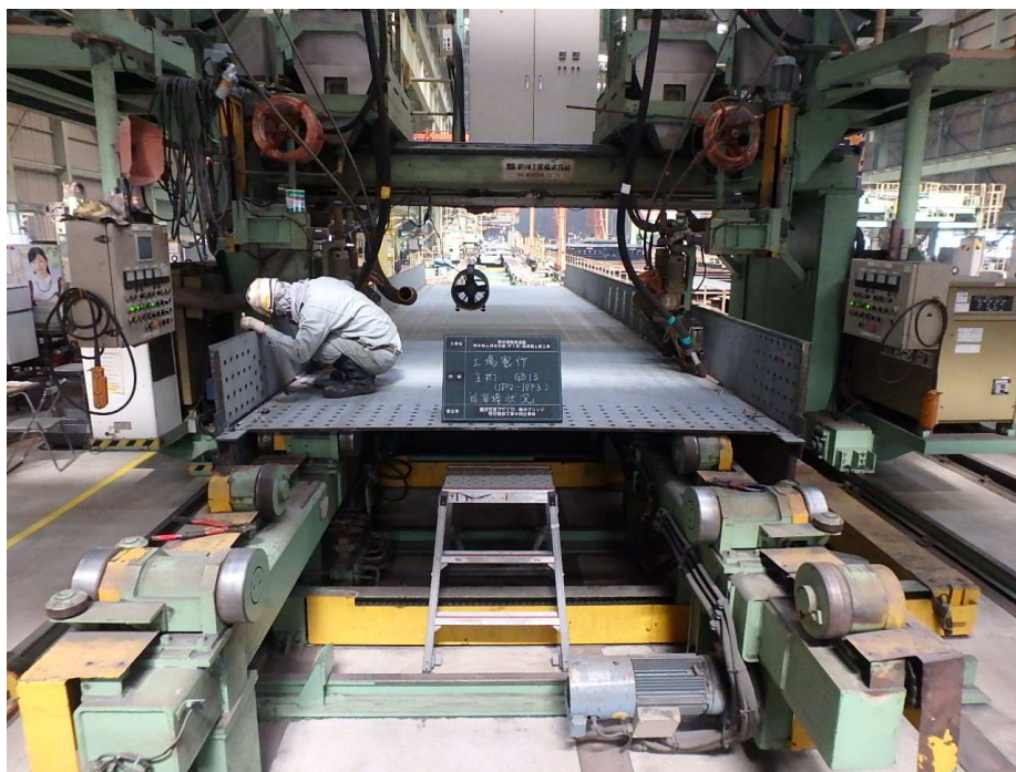
橋梁部材の溶接状況(ロボット溶接)
