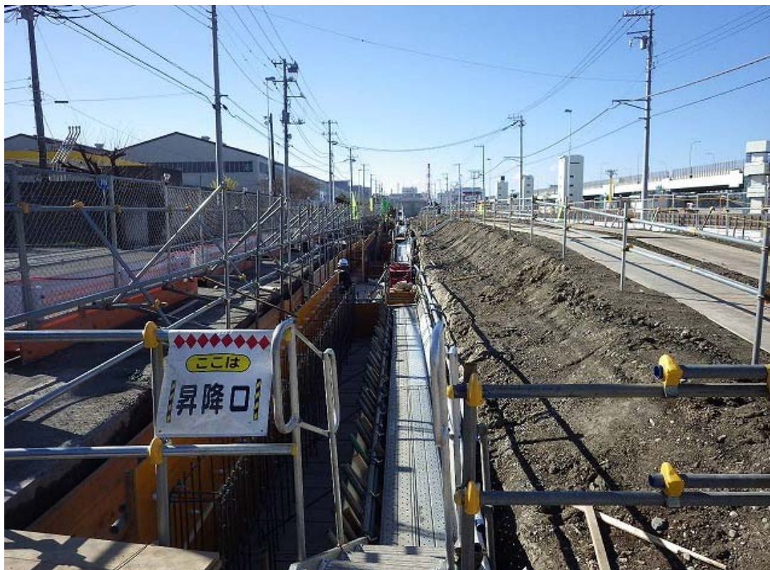
写真② 重力式擁壁工 施工状況
