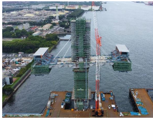
MP2 張出架設 6BL 令和5年10月
