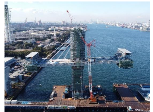
MP2 張出架設 10BL 令和6年2月
