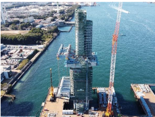
MP2 ピロン柱 コンクリート柱施工 張出架設 移動作業車組立 令和5年2月
