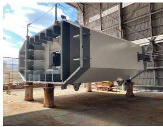
工場製作 MP4主塔中段ブロック 令和6年1月
