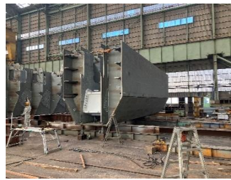
工場製作 MP4主塔上段ブロック 令和6年1月
