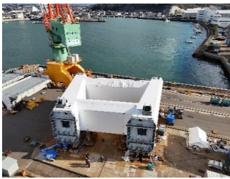
工場製作 MP4主塔下段ブロック 令和6年1月
