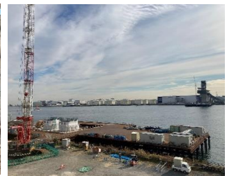
現地工事 MP4栈台全景 令和6年1月
