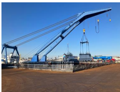
MP3主塔基部ブロック現場据付状況① 令和5年12月 （400t吊り起重機船による据付作業）
