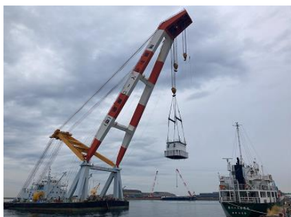
主塔基部ブロック浜出し作業 令和5年12月（JFE津製作所） （650t吊り起重機船で作業船へ積み込み）
