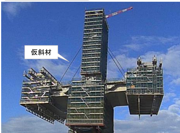
仮斜材設置完了
