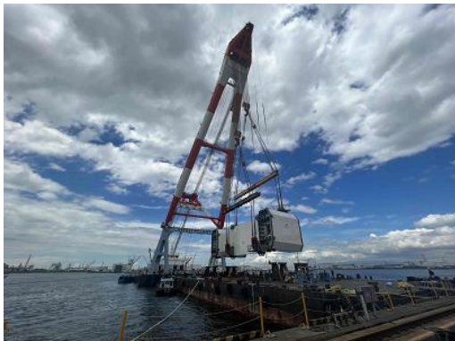
主塔転送ブロック浜出し作業 積込: 令和5年8月 IHI堺工場 (2,050t吊り起重機船+1,500t級台船)
