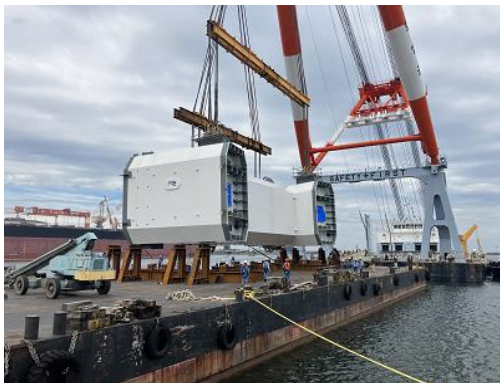
主塔転送ブロック浜出し作業 積込: 令和5年9月 JFE津製作所 (2,050t吊り起重機船+1,500t級台船)
