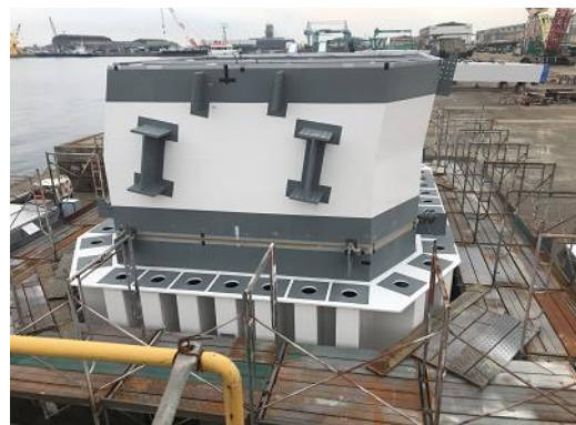
MP3主塔基部 令和5年10月製作完了 基部ブロック1基＝約210t
