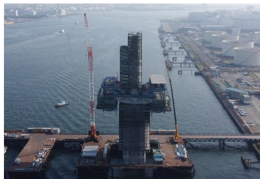
MP2 ピロン柱 コンクリート柱施工 張出架設 移動作業車組立 令和5年3月
