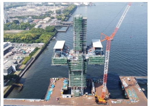
MP2 張出架設 2BL 令和5年5月
