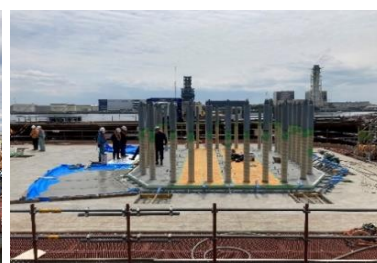
現地工事 MP4ベースプレート架設 モルタル打設状況 令和5年5月
