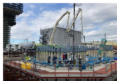
現地工事 MP4フーチング コンクリート打設状況 令和5年3月
