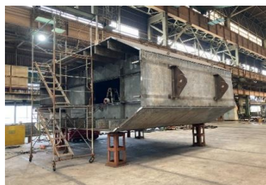
工場製作 MP4主塔塔柱 令和5年5月
