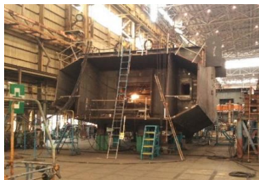
工場製作 MP4主塔隅角 令和5年4月
