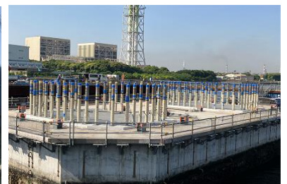
現地:MP3ベースプレート据付後 グラウト充填完了 令和5年4月
