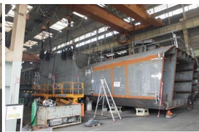
工場製作 主塔(主桁位置)場内確認組作業状況 (J4Y-J6Y) 令和5年6月
