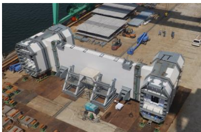
工場製作 主塔上段水平梁地組立状況 (J3-J4) 令和5年4月
