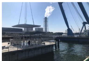
現地:MP3ベースプレート据付作業 (400t吊り起重機船)1プレート=約90t 令和5年3月
