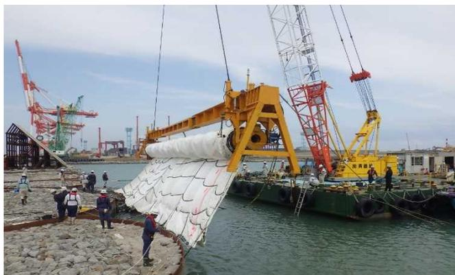
写真 固化処理土を投入している状況です。
