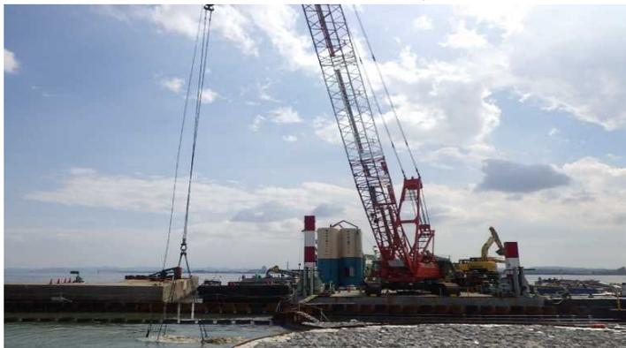
写真 裏込石(3)をケーソン越しに直投している状況です。
