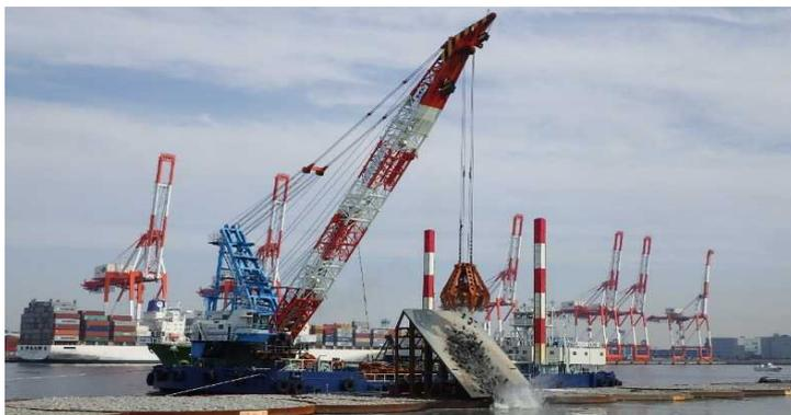
写真 機械式シート敷設工法にて防砂シートを敷設している状況です。
