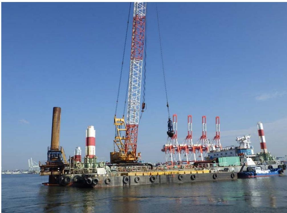
写真② 裏込石(5~50kg/個)を投入している状況です。
