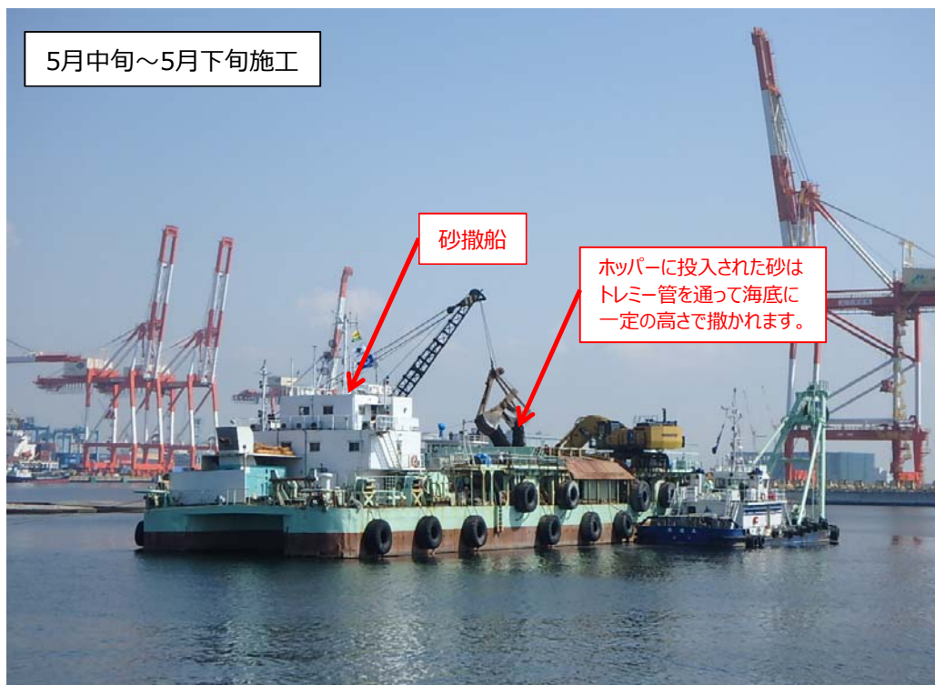
写真② 敷砂工：砂撒船で砂を海底に撒いている状況です。
