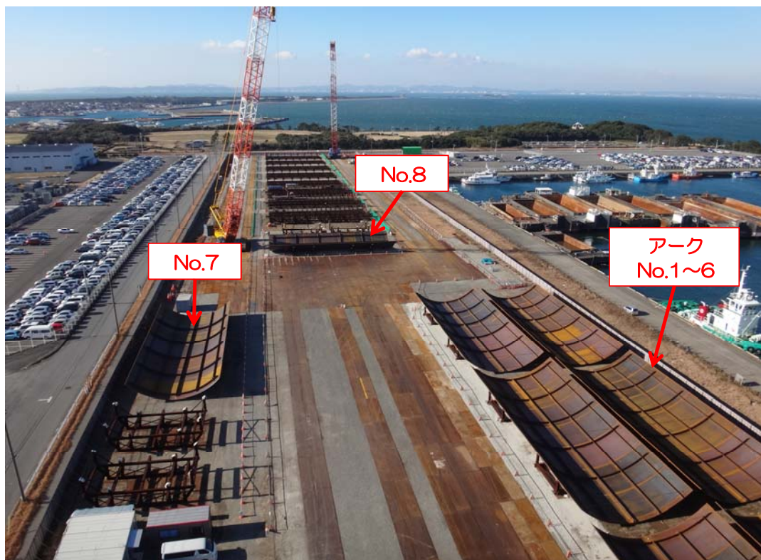
写真② アークを仮置きしている状況です。
