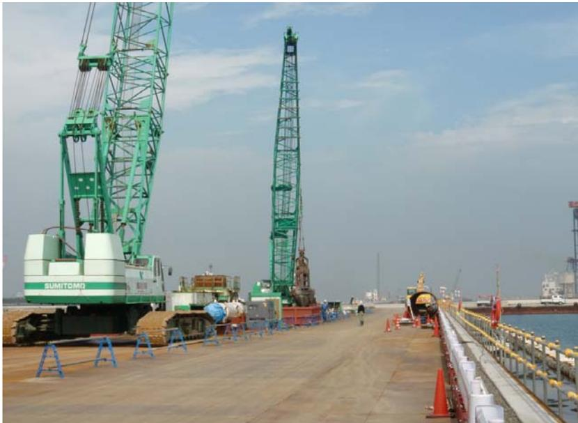
今月より、主工種であるクレーンレール基礎工の施工に着手しました。11月下旬にかけて打込杭42本(4組施工)の施工を行います。
