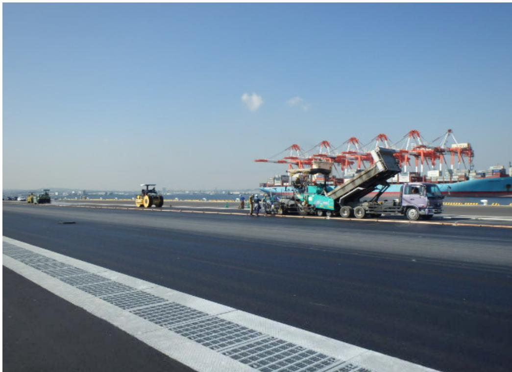
写真① 北側シャーン通路部 アスファルト舗装 (表層)
