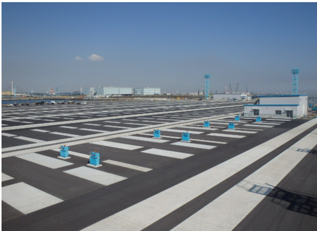
写真② 蔵置部 (コンテナを置く所) アスファルト舗装完了
