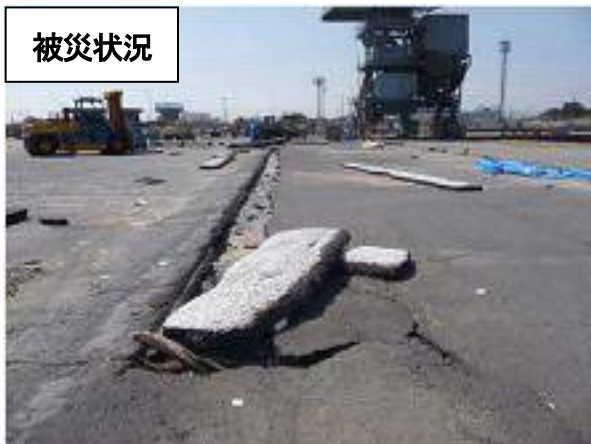
損壊したG岸壁のエプロン部と荷捌き地
