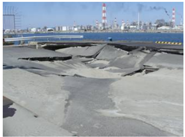
陥没により損壊した南公共ふ頭の荷捌き地
