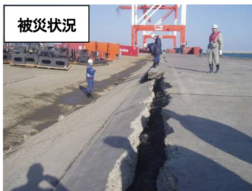
大きく亀裂が入った岸壁エプロン部
