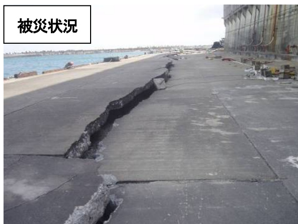
岸壁エプロン部に亀裂がはしり段差が発生
