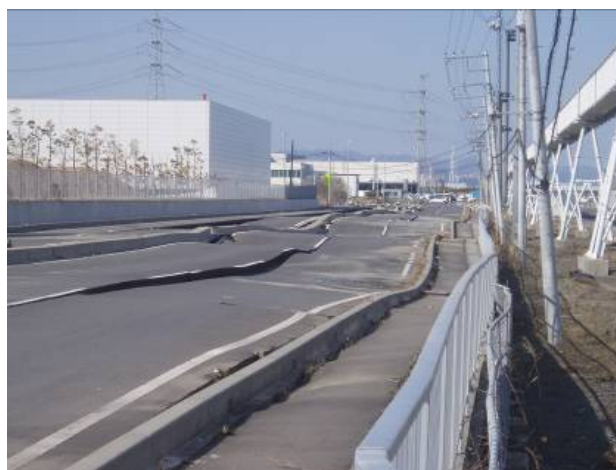
液状化で路面が波打った臨港道路5号線
