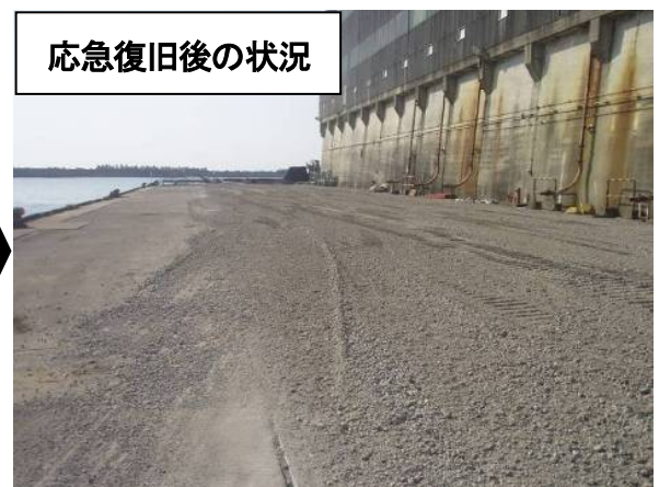
碎石を敷設しエプロン部の段差を解消
