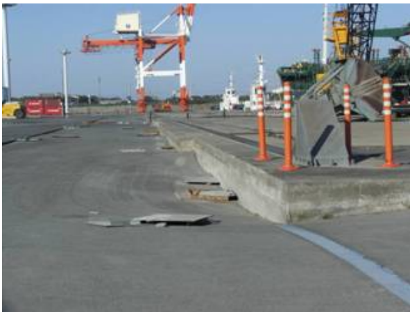
岸壁エプロン部に段差が生じた北公共ふ頭
