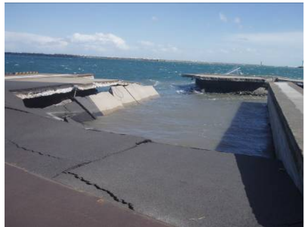
先端部の護岸が流出した第2ふ頭
