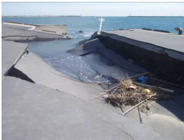
先端部が陥没崩壊した第1ふ頭
