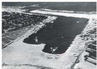
昭和40年 中央航路掘削
