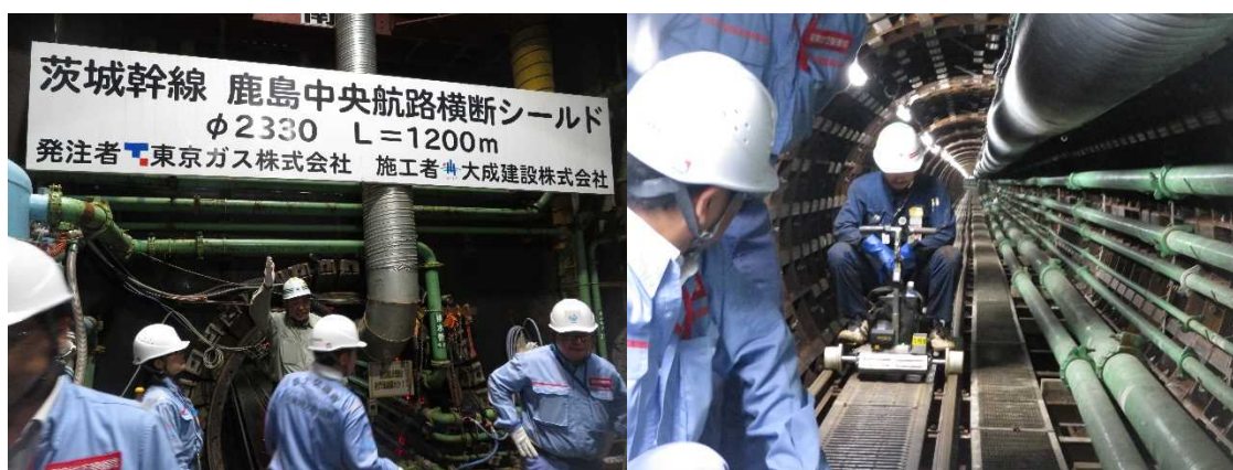
図 (左)発進立坑のシールド出発地点 (右)坑内を移動する専用の台車
