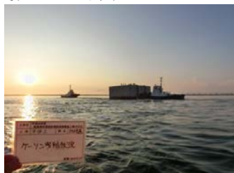
ケーソン曳航状況
