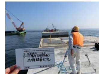
据付位置誘導状況
