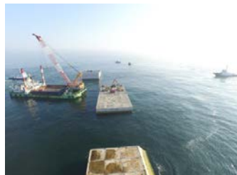
据付位置引き込み状況
